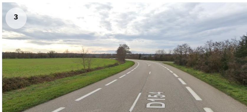
Une partie des voies de transit bénéficient de bandes cyclables permettant des déplacements doux à plus large échelle. Ici, la RD 154 en direction de Colombier-Saugnieu Source : Google Street View – Février 2023
