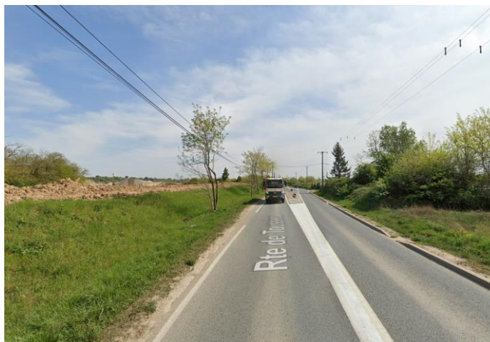
La RD 147 au profil routier, qui traverse les zones de carrières.
