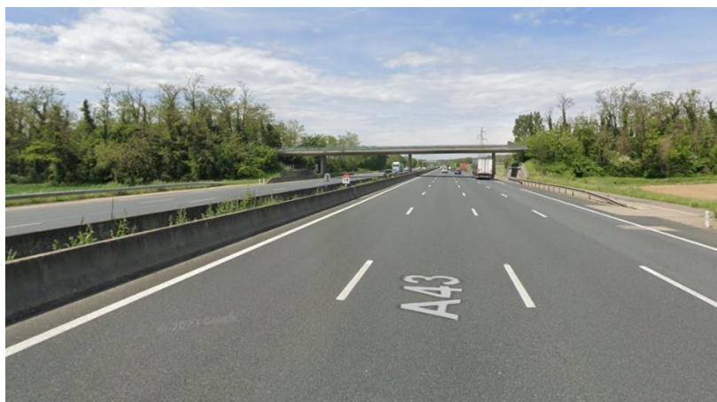
Autoroute A43 traversée par l'allée du vieux Moulin.
