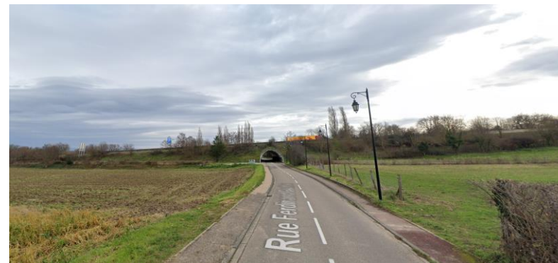
L'A 432, « frontière » entre le hameau de Poulieu et le reste de la ville Source : Google Street View – Décembre 2022
