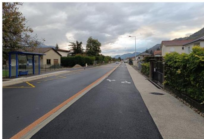
Aménagement d'une route départementale pour une piste cyclable (Ville Le Versoud)
