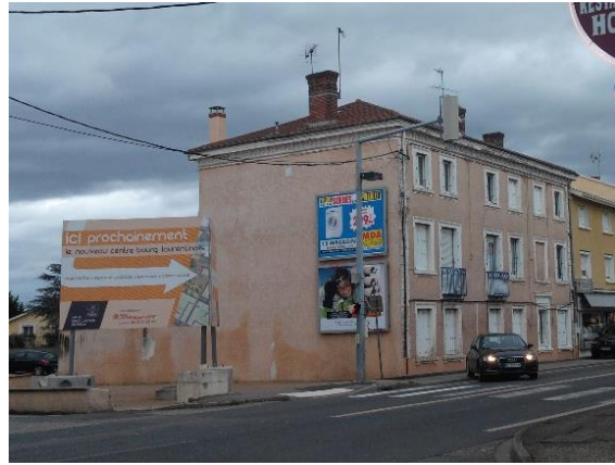
Panneaux démontés en mai 2018
