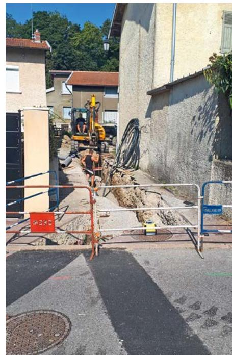
Dans la remise en état du réseau, une fois les canalisations posées, les réseaux sont enterrés, et les routes et enrobés sont refaits à neuf au besoin.
